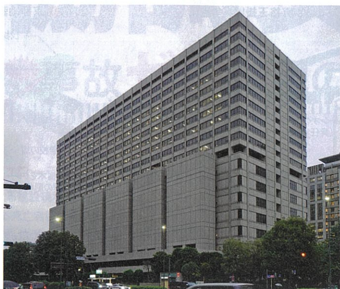
資料2 ■ 建設現場で起こった事故の責任割合については各地でたびたび訴訟が起こっている。写真は東京地裁の庁舎 (写真:日経クロステック)
