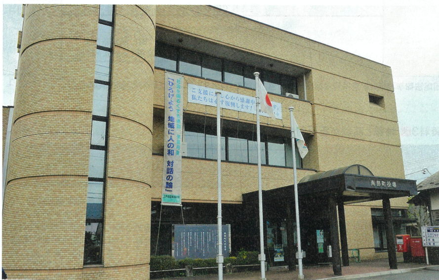
資料1 ■ 南部町役場福地支所の庁舎。3町村の合併で成立した同町では、新庁舎の必要性や建設地を巡って議会内で異論があった(写真:朝日新聞社)
